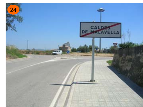
GI-674, intersecció GIV-6741. Una rotonda regula el trànsit entre les dues carreteres. Falten passos de vianants.
