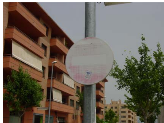
Senyal en estat deficient
