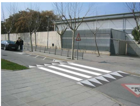
Pas de vianants elevat i senyalització horitzontal.
