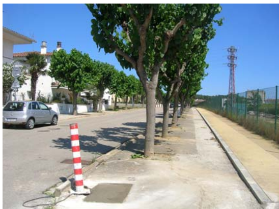
Imatge 4. Av. Catalunya, intersecció travessia Taronja. A la dreta dels arbres hi ha dos espais segregats sense cap senyalització que indiqui a qui correspon cada espai.
