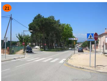
GI-674, intersecció amb els carrer Solell i Sant Jordi. Ni el semàfor intermitent ni el senyal de velocitat tenen una ubicació lògica.
