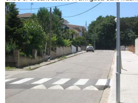
Intersecció avinguda Sant Maurici/passeig Granja. Passos elevats. Aparcament sense senyalitzar.
