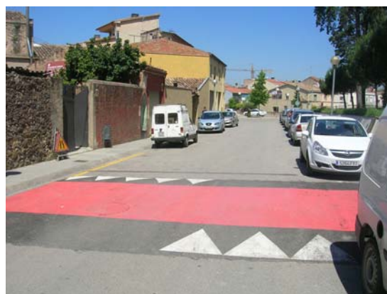
Imatge 25. Carrer Rera Muralla a prop de la carretera GI-674. Una plataforma elevada serveix per a reduir la velocitat a l'anella interior.
