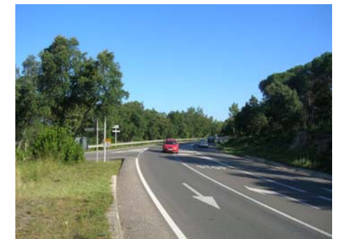
Molts cotxes envaeixen el carril de gir per a augmentar el radi de gir traçant la corba.
