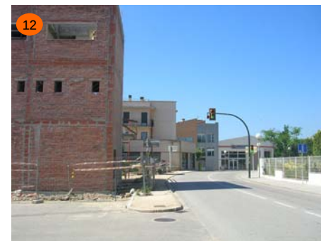
Avinguda Doctor Furest, intersecció amb el carrer Termes Romanes. Darrera el CAP en construcció hi ha un gran aparcament.
