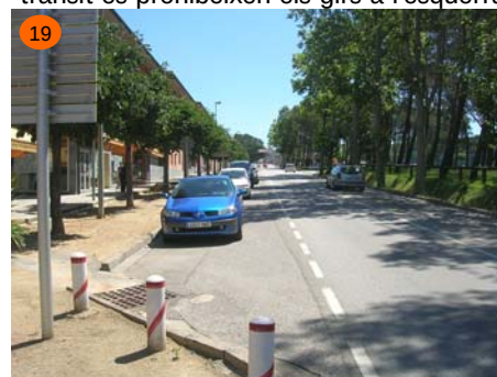
GI-674 a l'est del c. Girona. Per a evitar un excés d'amplada dels carrils de circulació s'ha marcat un carril d'aparcament molt ample.
