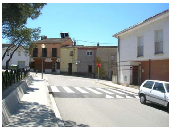
Imatge 24. Carrer Rera Muralla, intersecció amb el carrer Roques. Un altre tram de l'anella interior. Per a reduir la velocitat s'ha instal·lat un pas de vianants elevat.
