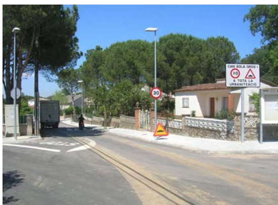
Imatge 30. Can Solà Gros – avinguda Antoni Gaudí. A l'entrada de la urbanització s'ha instal·lat una plataforma elevada i s'indica el límit de velocitat amb abundant senyalització.
