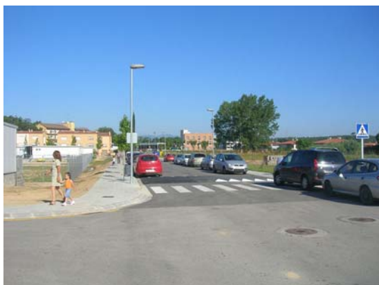
Imatge 10. Carrer Onze de Setembre davant la zona escolar. La instal·lació d'orelles milloraria la visibilitat i impediria l'estacionament sobre el pas de vianants.
