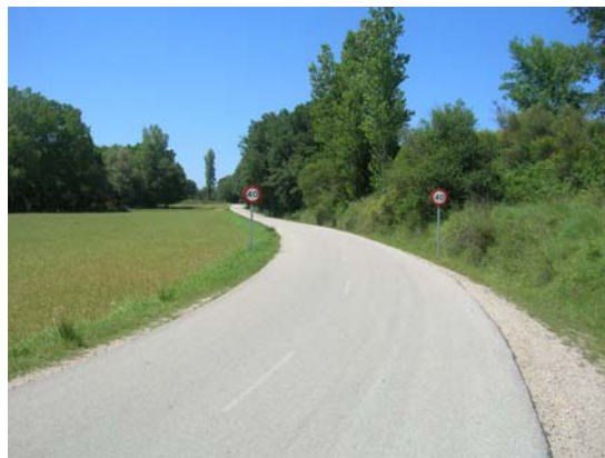
Imatge 33. Camí asfaltat entre el carrer Ponent i la urbanització Can Solà Gros. Es repeteixen els senyals que indiquen una velocitat màxima de 40 km/h.
