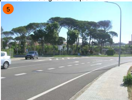
GI-673, intersecció avinguda Doctor Furest. La carretera té carril de gir i d'incorporació.
